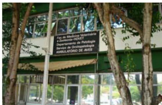
Fachada do Serviço de Ambulatório de Aves. Campus São Paulo
